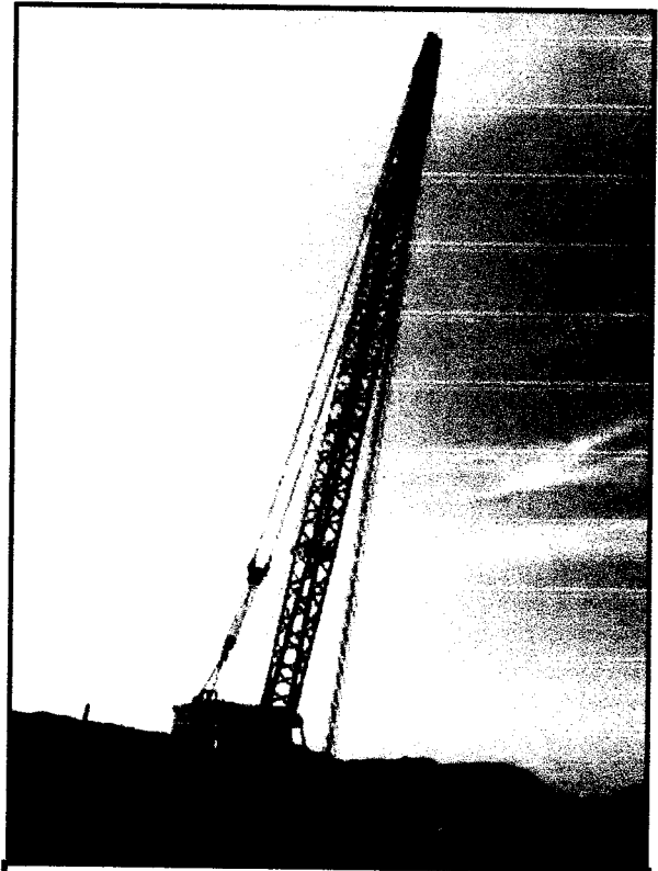
Imagen N°03.- Equipos pesados paralizados.
