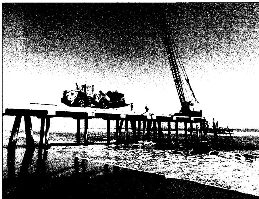
07.04.07.07 COLOCACION DE VIGAS TRANSVERSALES.
