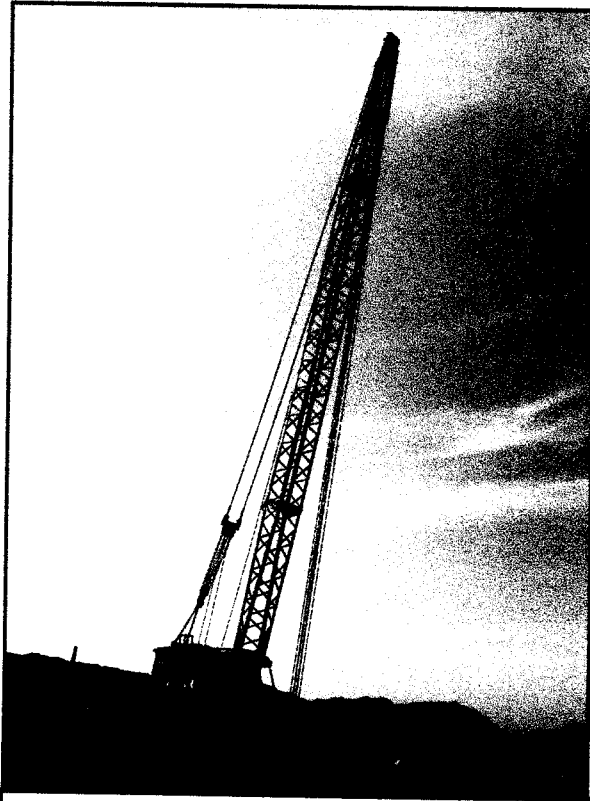
Imagen N° 03.- Equipos pesados paralizados.
